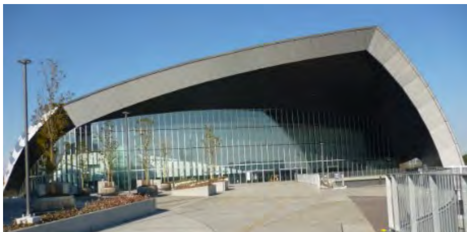
武蔵野の森総合スポーツプラザ（メインアリーナ2階正面入口を臨む）
